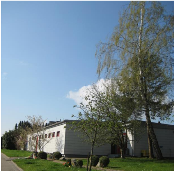
Nördlicher Bereich des bestehenden Verwaltungsgebäudes
