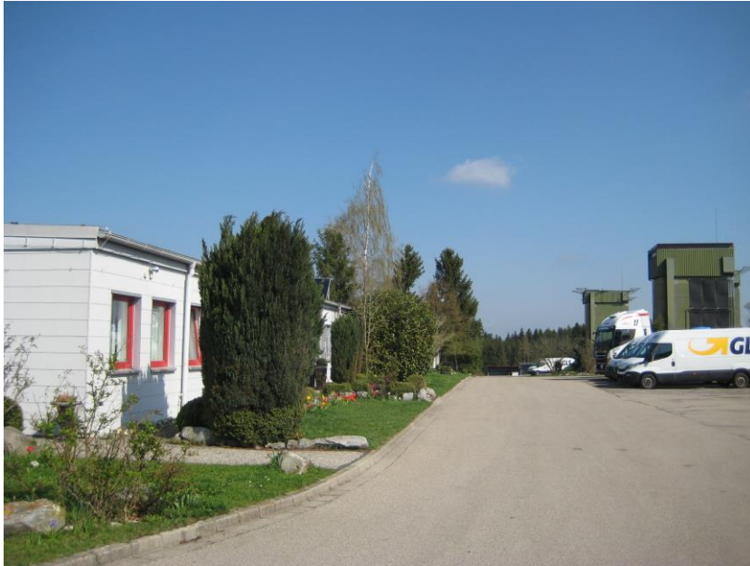
Östlicher Bereich des bestehenden Verwaltungsgebäudes
